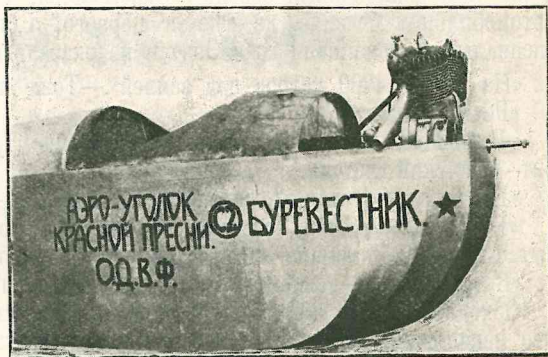
Мотоциклетный мотор „Харлей-Давидсон“ в 11 сил на „Буревестнике“.
