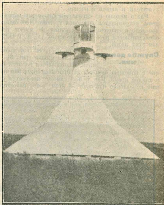
Рис. 6. Маяк на Кройдонском аэродроме, дающий отраженный свет.
